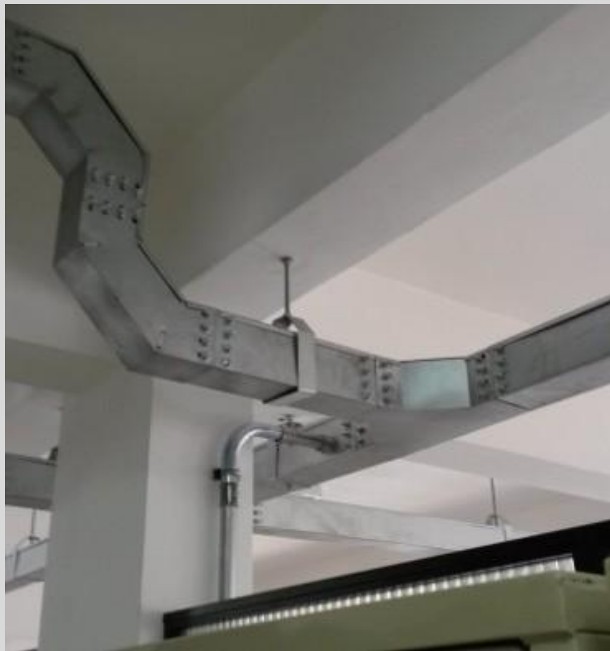
Montagem de Infraestrutura - M. dias Branco
