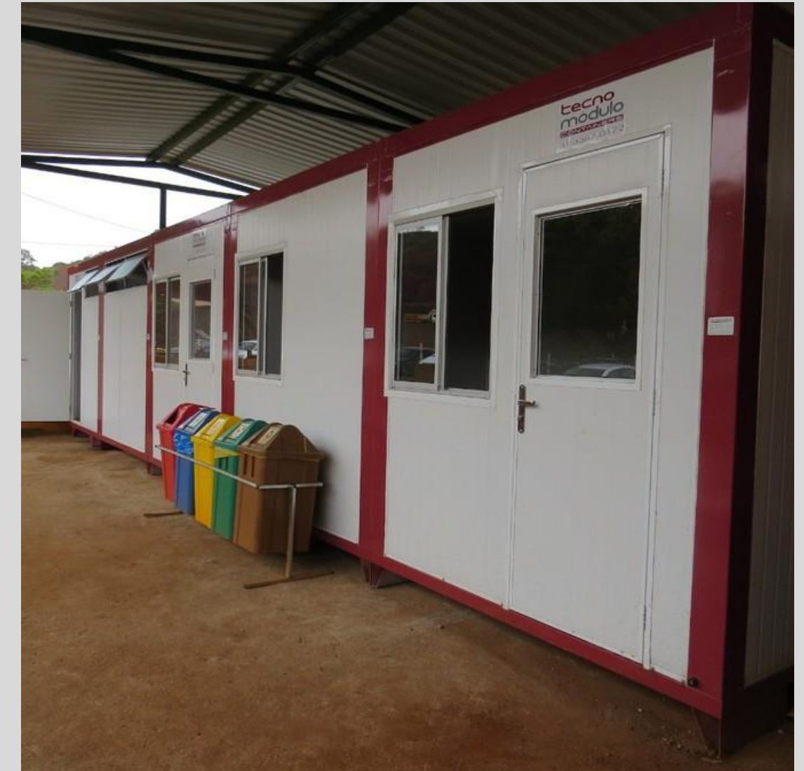
Canteiro de obras
