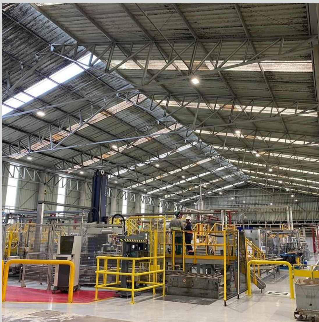
Instalação de 120 luminárias e infraestrutura - Heineken Alagoinhas
